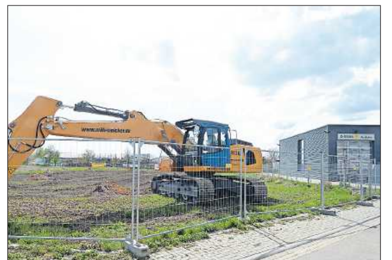
Das künftige 8com-Grundstück neben der Dekra-Prüfstelle. FOTO: LM
